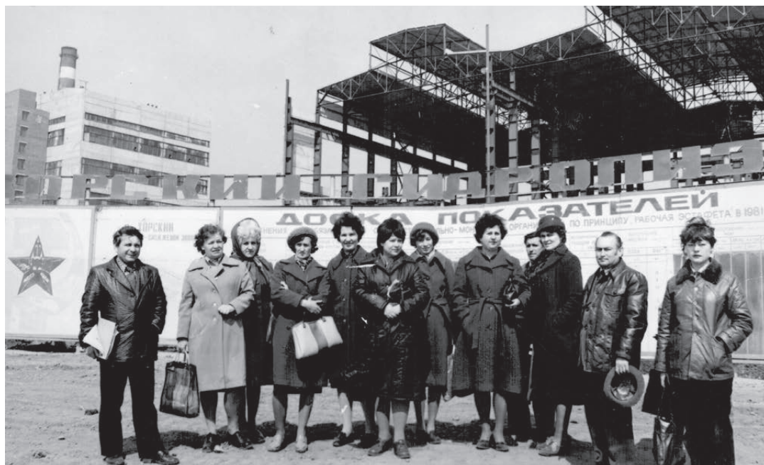
Группа строителей на фоне строящегося Хорского биохимзавода
